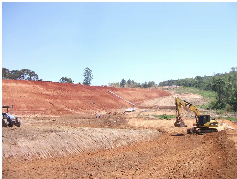
Foto 1: Conclusão do selamento do novo depósito.
