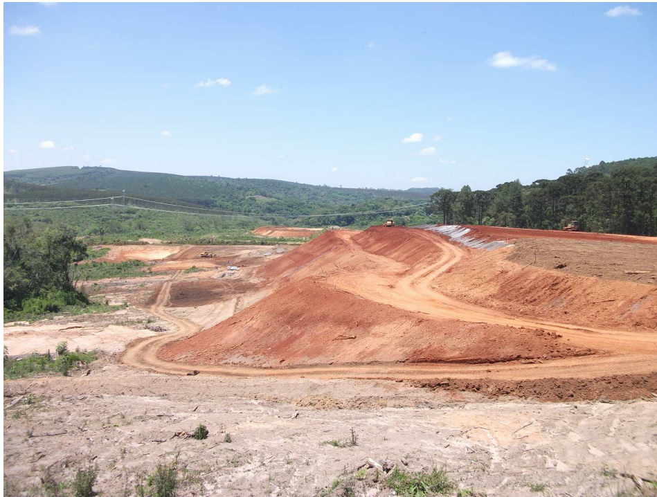
Foto 2: Conclusão do selamento do novo depósito.
