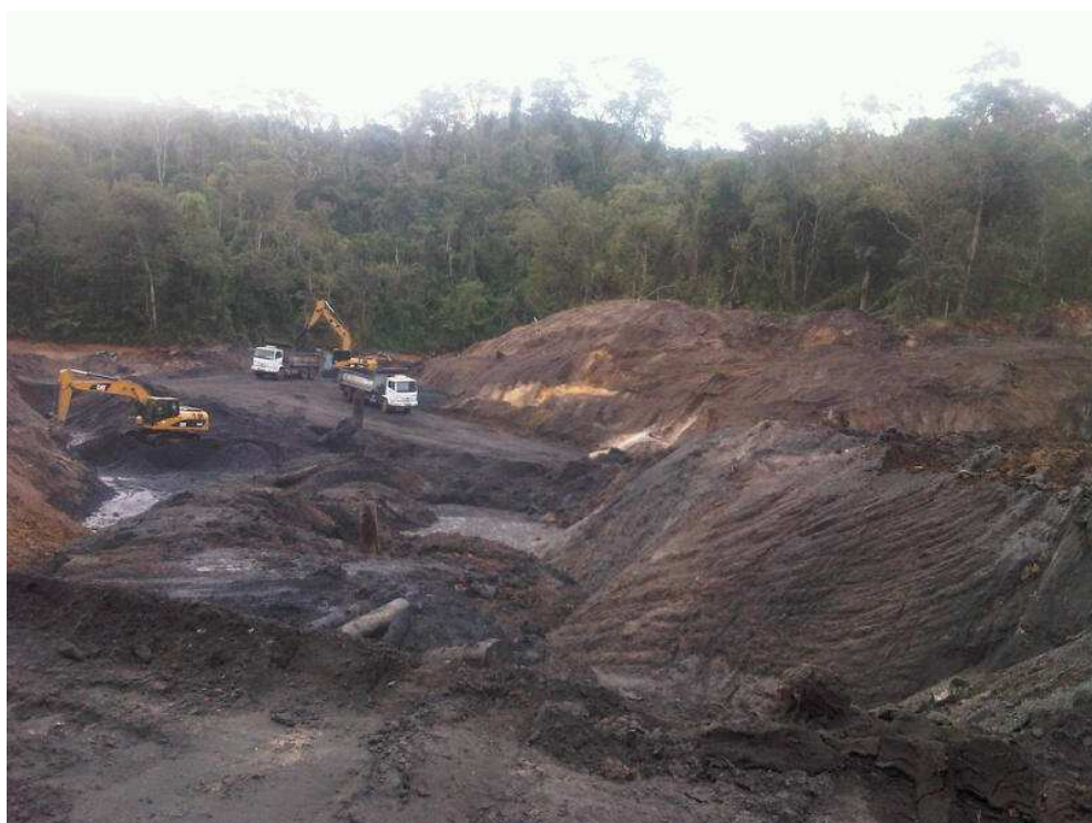
Foto 1: Retirada do rejeito de carvão do lavador
