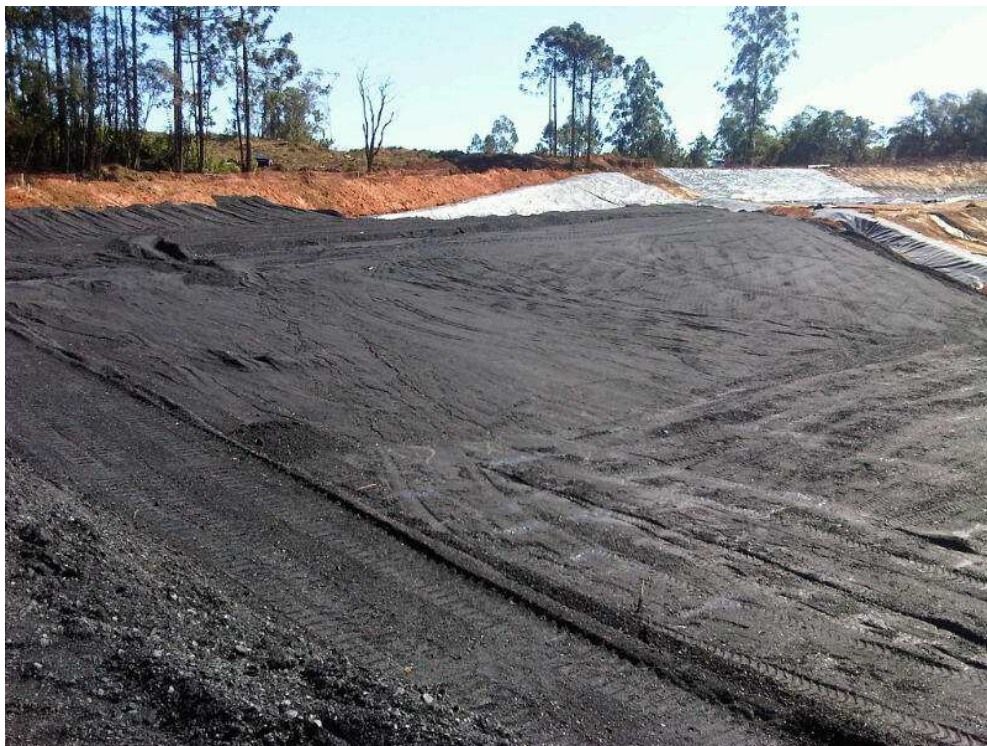
Foto 3: Disposição do carvão no novo aterro industrial
