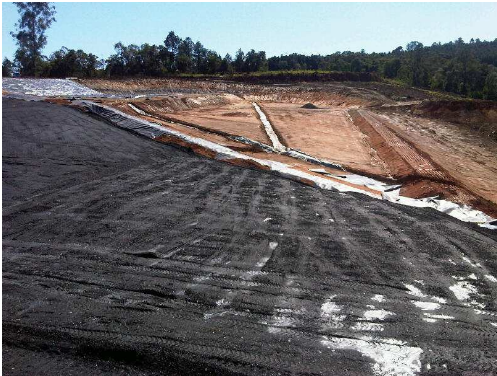
Foto 2: Disposição do carvão no novo aterro industrial.
