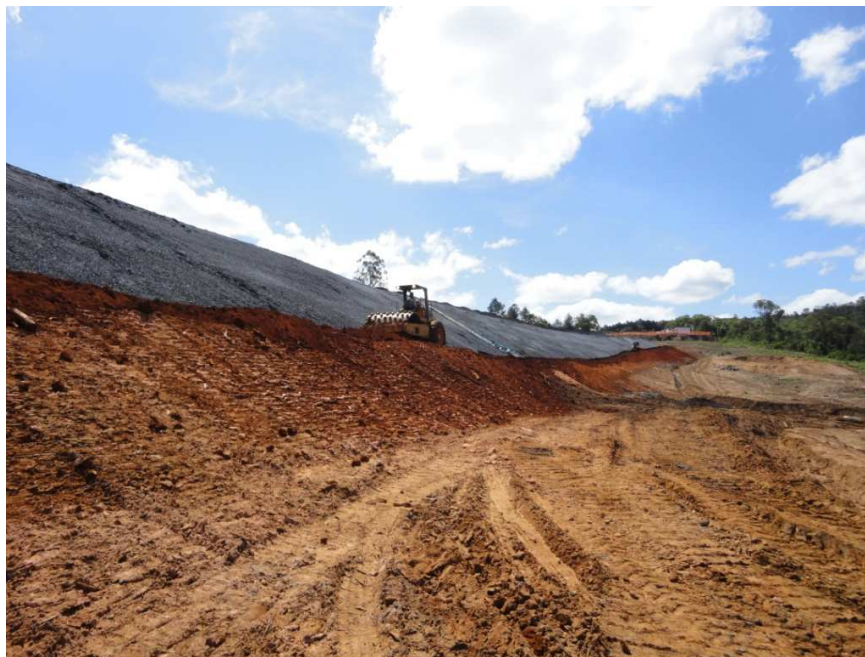
Foto 2: Selamento do aterro
