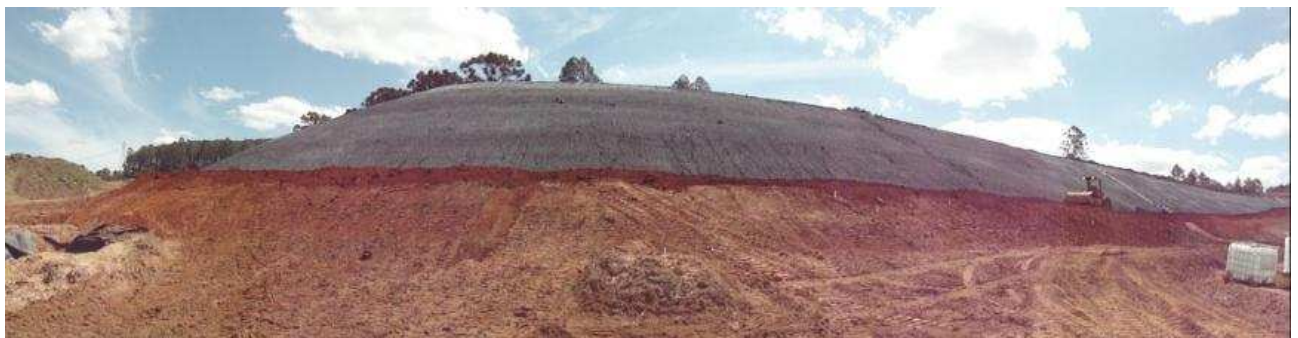
Foto 3: Selamento do aterro
