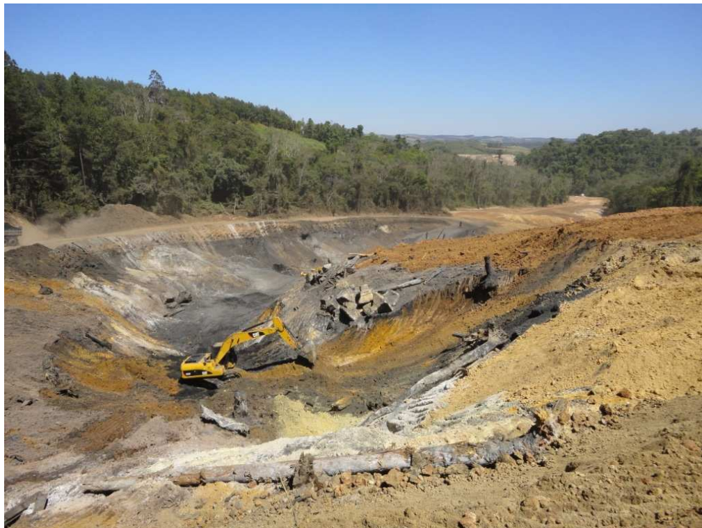
Foto 1: Remoção dos rejeitos de carvão
