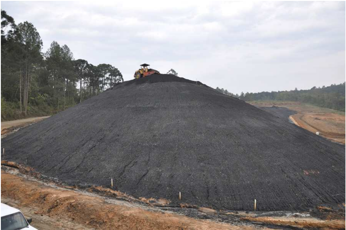
Foto 2: Deposição dos rejeitos de carvão
